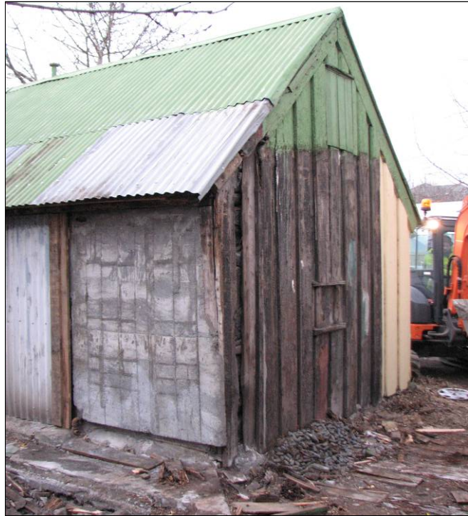
Mynd 1. Uppistandandi hús á Vaktaralóð, horft til SV
